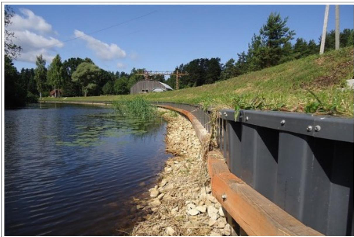
Una delle principali funzioni delle palancole in pvc è di prevenire l'impatto dell'erosione delle acque sulle strutture colpite da alluvioni.
