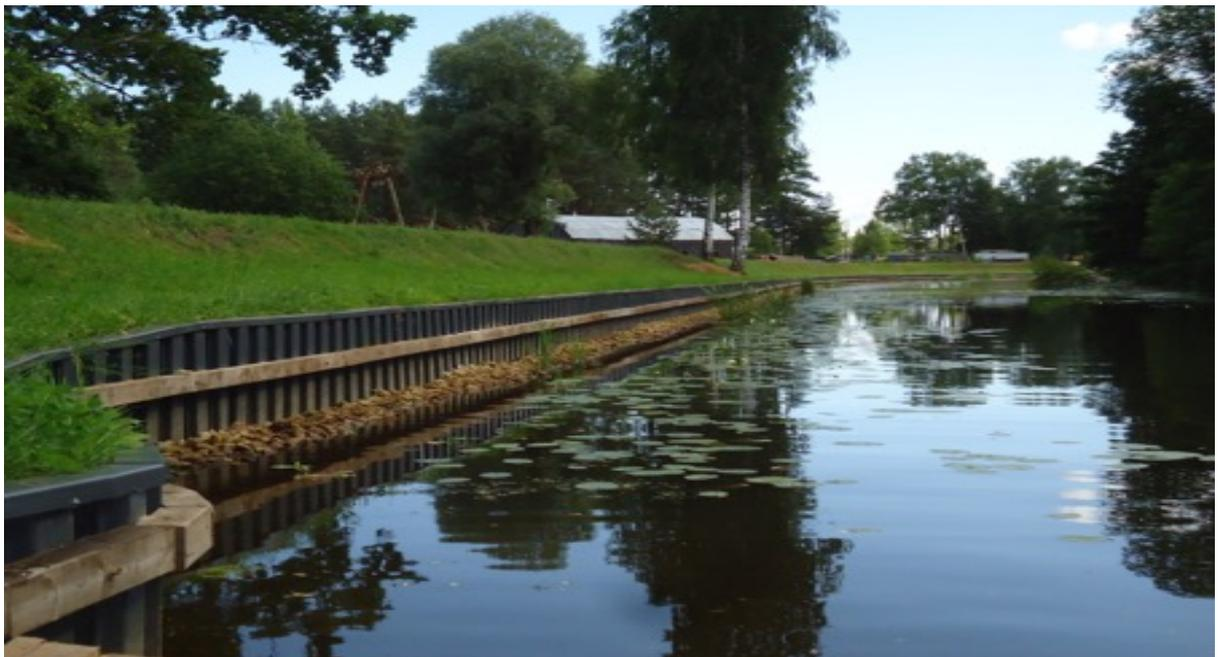
ESEMPIO DI PALANCOLA IN PVC CON TIRANTI MOD GW 610/9
